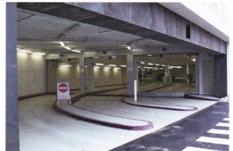
Einfahrt in die Tiefgarage, Bahnhofstraße
