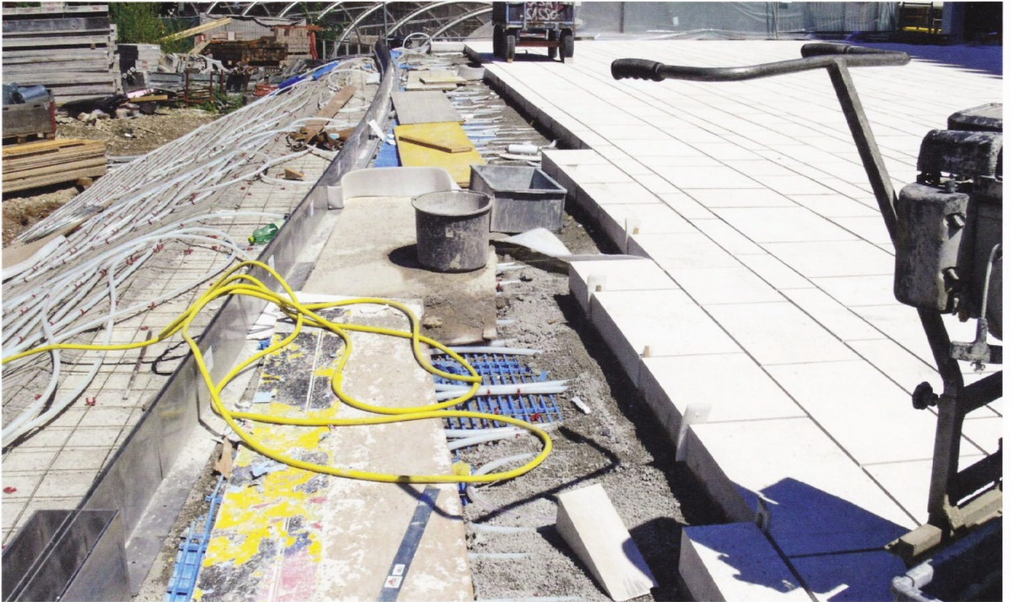
Der Vorplatz zum Haupteingang ins Musiktheater bekommt eine Bodenheizung, gespeist von der Abwärme des Hauses, zur Schnee- und Eisfreihaltung. Darauf wird das Pflaster verlegt (Blick zur Landstraße).
