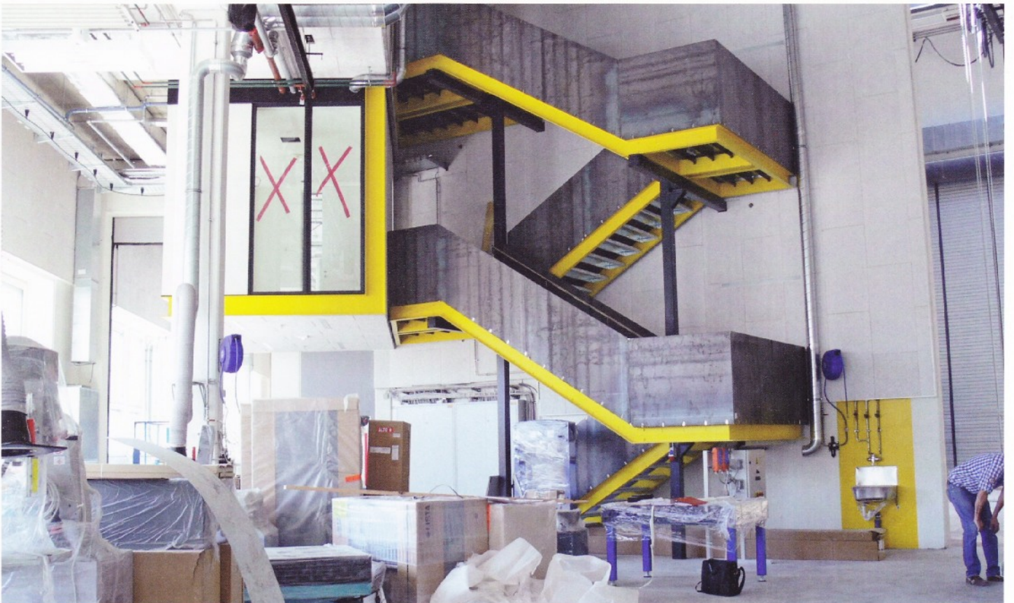
Blick in den Werkstättenbereich, hier in die Schlosserei mit Innenstiege. Links die Fenster nach Süden, rechts ein Blick durch die Tür zum Montagesaal. Die Werkstätten werden im Herbst den Betrieb aufnehmen.
