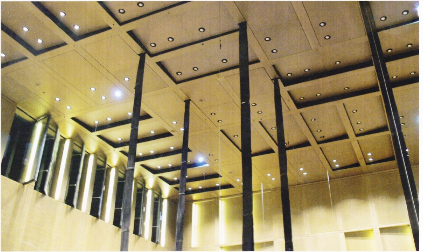
Brucknersaal (Orchesterprobensaal): Decke und Wände, links Fenster zur Blumauerstraße. Die lotrechten Streifen sind Zuleitungen zu Tragkonstruktionen für Technischelemente. Diese sind im Normalbetrieb hochgezogen.
