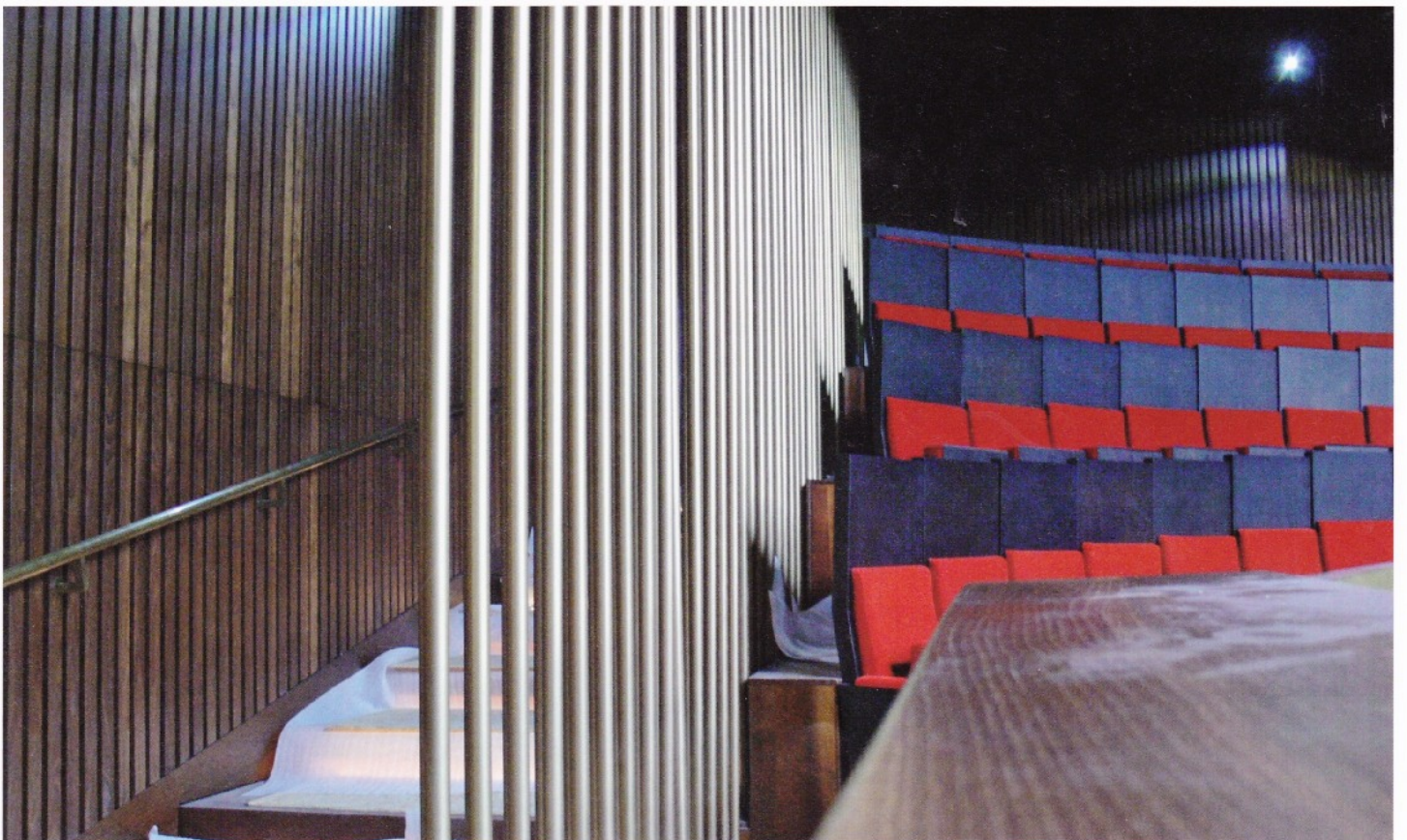
Detail der „Trennwand“ vor der Saalaußenwand. Sie besteht aus zarten stabförmigen Elementen und dient einer guten Akustik. Hinten die Sitze des 2.Ranges.
