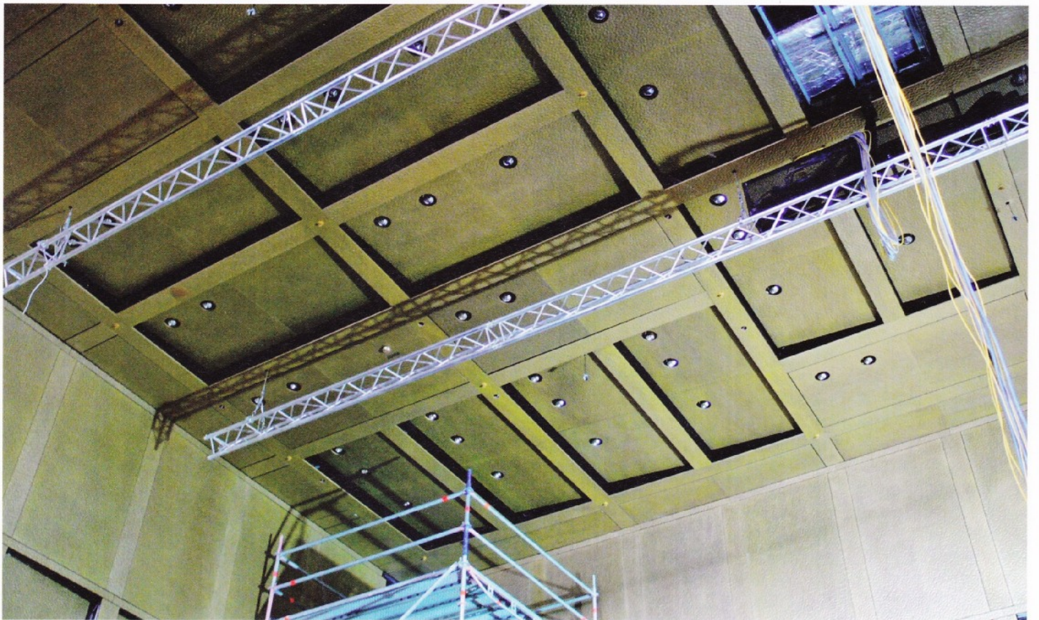
Wände und Decke des Orchesterprobensaals in goldoptischer Echtmetallbeschichtung - fast fertig gestellt. Derzeit wird an der Fensterwand (entlang Blumauerstraße) gearbeitet.
