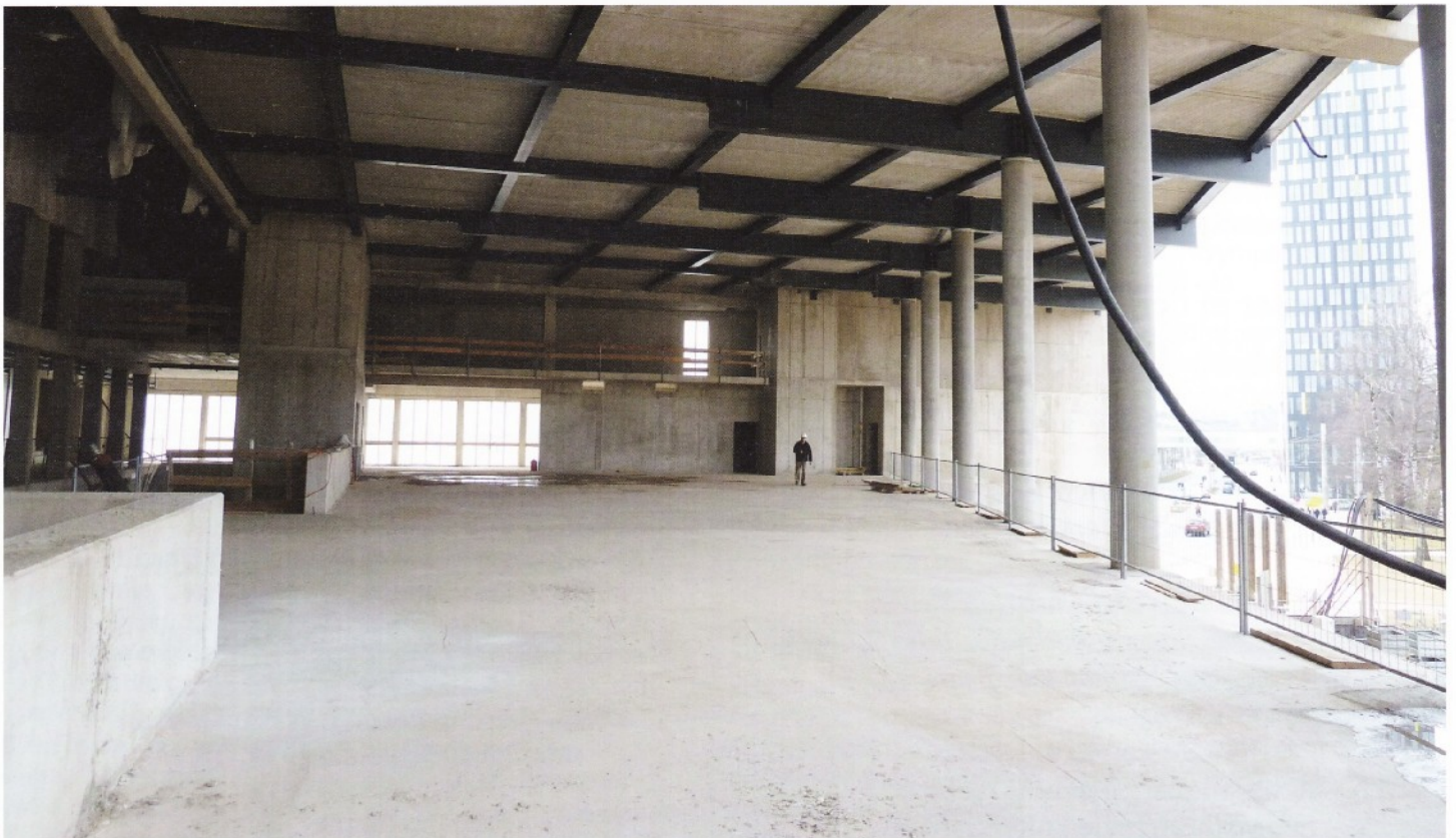
Das Hauptfoyer. Rechts der Volksgarten, im Hintergrund der Turm der Energie AG. Über dem Foyer befindet sich das Restaurant. Die Stahlbauteile an der Decke sind Teile einer hohen Fachwerkskonstruktion, die den ganzen Bereich trägt.
