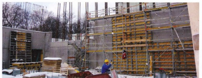
02.02.10: Die Außenwand zur Blumauerstraße mit den Fenstersäulen ist im Entstehen.
