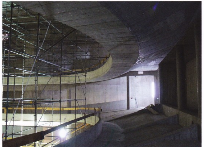
1. Rang hinten, darüber 2. Rang, links Rangseitenarme. Die Saaldecke ist eingerüstet.
