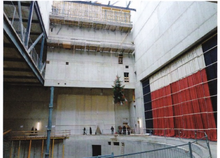
Blick auf den Bühnenbereich. Unten Umfassungswand der Transportdrehscheibe, rechts „Theatervorhang“ als Abschluss zum Saal, hinten der Eingang zur Seitenbühne, der Gleichenbaum schwebt vom Dach, darüber der Bühnenturm. Die dicke Stahlsäule links ist provisorisch und kann erst entfernt werden, wenn der Dachbereich tragfähig ist.
