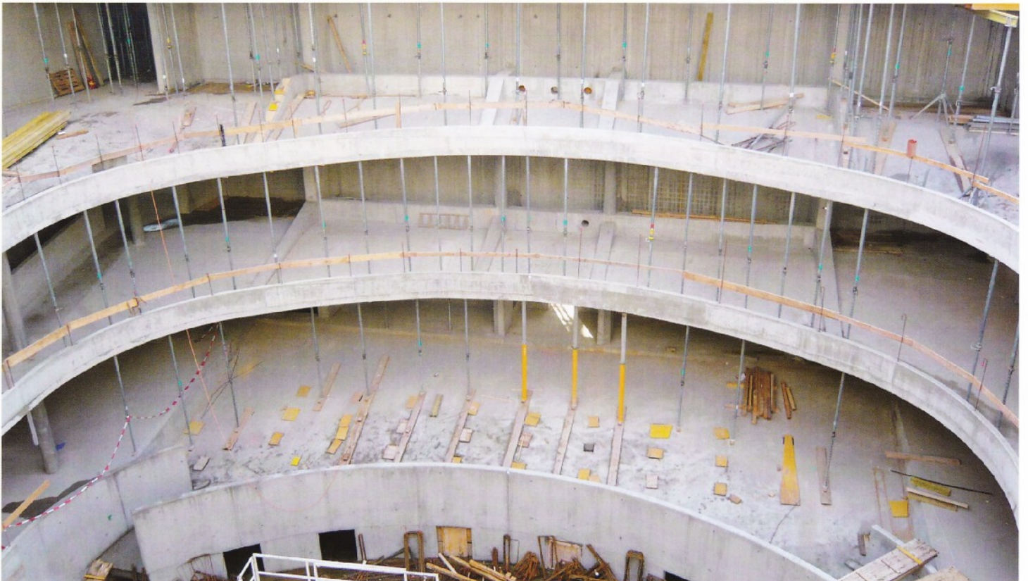
Saalrückseite: Der Rohbau des Auditoriums ist bereits fertig gestellt. Das Bild zeigt die Saalrückseite mit dem Hochparterre, den beiden Galerien und deren Decke. Der Saal wirkt breit, der Abstand zur Bühne von ganz hinten ist angenehm klein. Die Zusage guter Sichtverhältnisse wurde augenscheinlich erfüllt.
