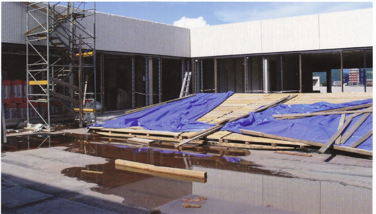
Atriumhof. Um ihn sind die Büros des obersten Geschoßes angeordnet. In seiner Mitte ist eine große Glasfläche zur Beleuchtung der Montagehalle vorgesehen. Diese ist derzeit noch mit Holz und Planen abgedeckt.
