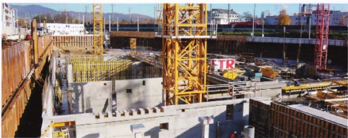
17.11.09: Auf den „Pilzen“ des 2. UG (ganz vorne) wird der Fußboden des Probensaales betoniert werden.
