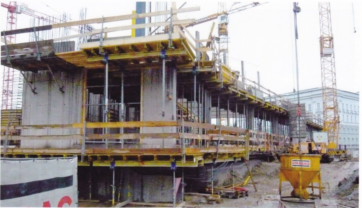
Der Eingangsbereich, hier von außen (in Straßenbahnnahe) gesehen, zeigt seine runden Stahlbetonsäulen. Der Krankübel im Vordergrund wartet auf den nächsten Beton für die Platte des 1. Ranges.
