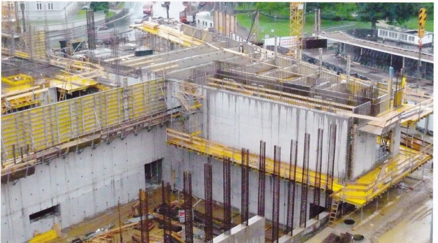
Von der Decke über dem Eingangsbereich sind bereits die Fertigteilträger (mit runden Löchern) verlegt. Rechts davon blickt man auf den Volksgarten mit der abbruchreifen „Milchtrinkhalle“, vorne in den Orchesterprobensaal.
