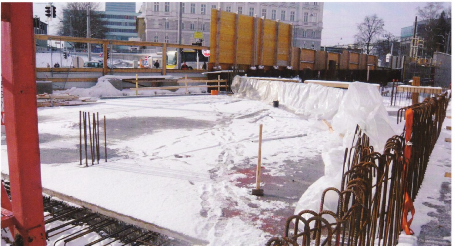
Einfahrtsbereich. Wo die Umplankung der Baustelle im Hintergrund durchsichtig ist, wird die Einfahrt von der Hauptverkehrsstraße in die Theatergarage erfolgen - seitlich vom Bühnenbereich. Auf dem Bild rechts erkennt man, durch die Folie sorgfältig geschützt, die Anschlusseisen der runden Begrenzungswand der Einfahrt.
