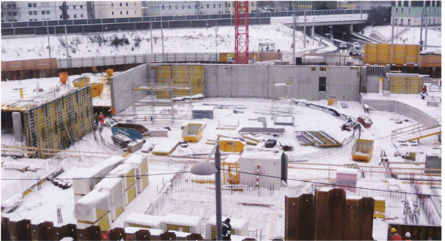
Bühnenbereich. Hinten und links sind die Umschließungsmauern der Unterbühne. Aus dem vom Schnee bedeckten Baumaterial zeichnen sich die Anschlusseisen des kreisförmigen Fundaments der Transportdrehseife mit 32m Durchmesser ab. Rechts ist die kreisbogenförmige Begrenzung des Orchestergrabens bereits betonierte.
