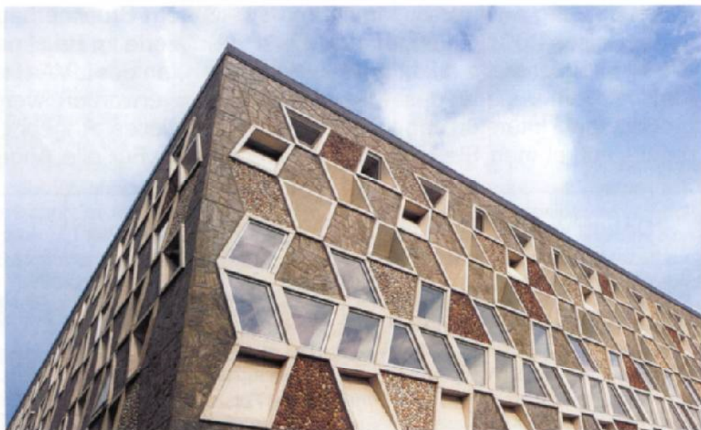
Der Bau wirkt nicht sonderlich spektakulär: ein rechtwinkliger Kasten mit grauen Konglomeratsteinplatten, strukturiert mit Trapez- und Rautenmustern.
