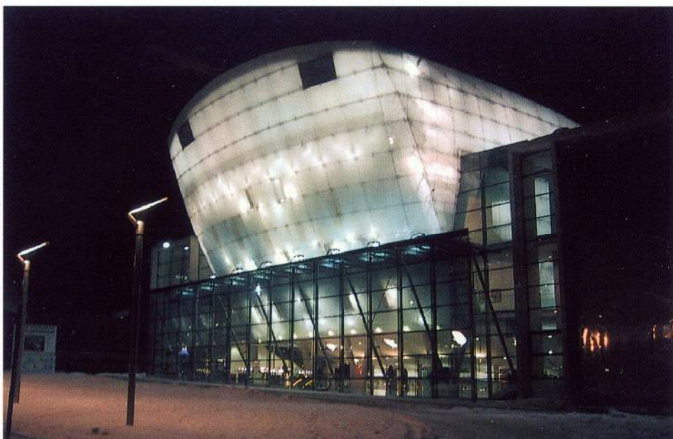
Ein markanter Blickfang: das von innen beleuchtete „Schiffsheck“ des Festspielhauses in St. Pölten.
