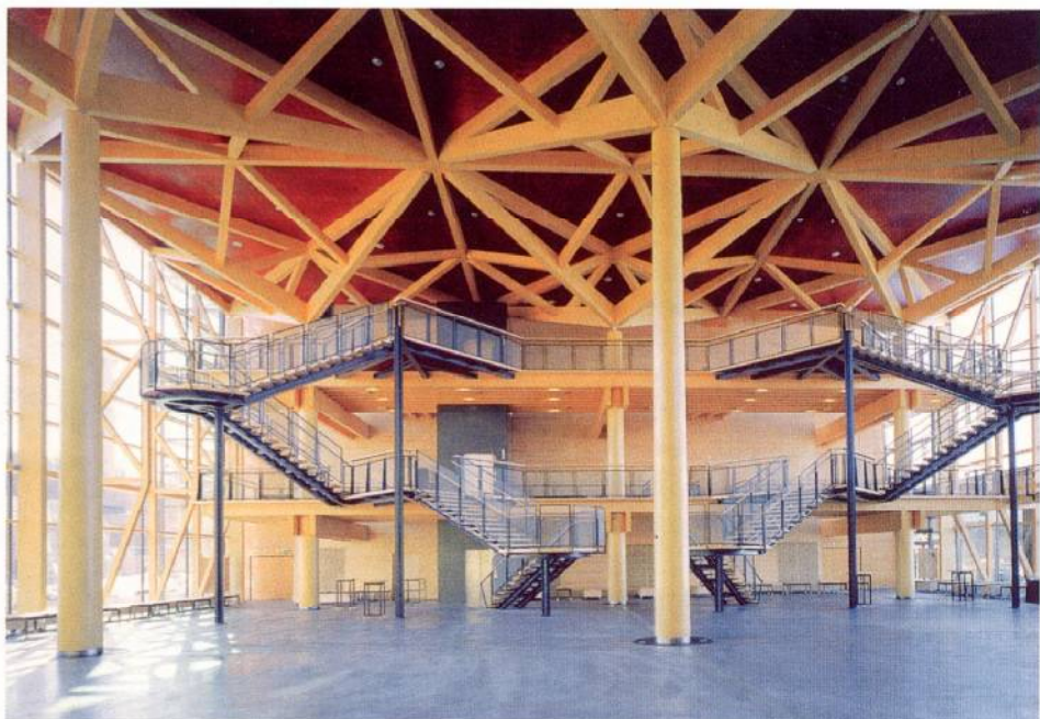
Die 14 Meter hohe Foyerhalle wird von sechs Holzsäulen getragen, von denen an der Decke jeweils sechs Sparren auseinander ragen. Das schafft die Illusion von Bäumen und Ästen.
