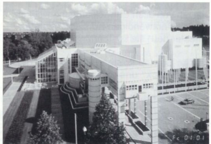
Die Formen sind klar und ebenmäßig, die Baumaterialien fügen sich zu einem harmonischen Ganzen: weiße Keramikplatten, grauer Granit und viel Glas, das elektrisch beheizt ist.
