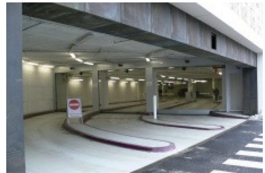
Einfahrt in die Tiefgarage, Bahnhofstraße
