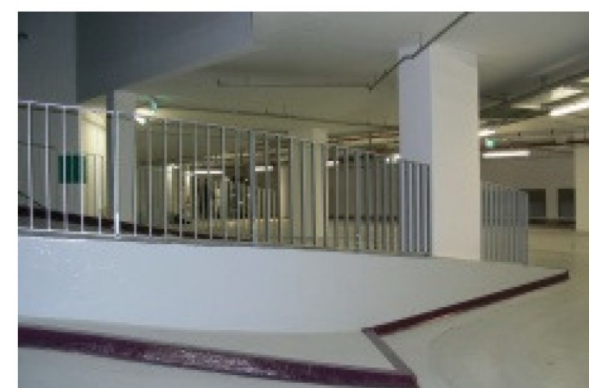
Rampen zwischen oberer und unterer Garage
