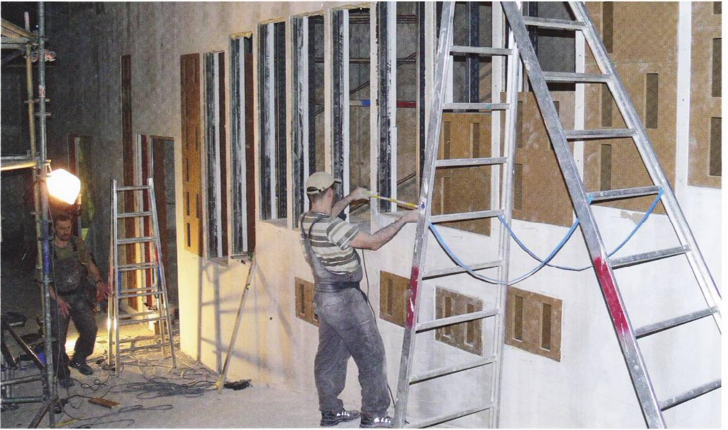
*In den Zwischen-Seitenwänden des 2.Ranges werden Helmholtz-Resonatoren eingebaut. In der Südseite ist die Einbauarbeit noch im Gang. An der Nordseite sind sie bereits fertig gestellt (siehe Seite 10).*
