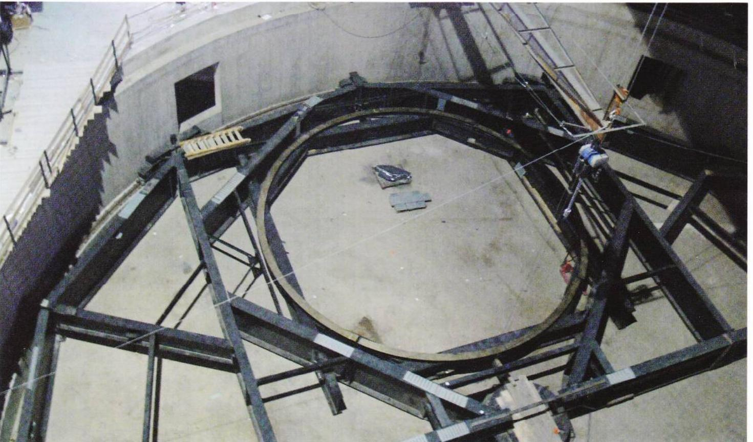
*Von ganz oben aus dem Bühnenturm ist die Einrichtung der Spieldrehbühne ( $\varnothing$  15m) in der Hälfte der Transportdrehseibe besonders gut zu sehen. Die im Vordergrund noch fehlende 2. Kreishälfte wird drei Hubpodien aufnehmen.*
