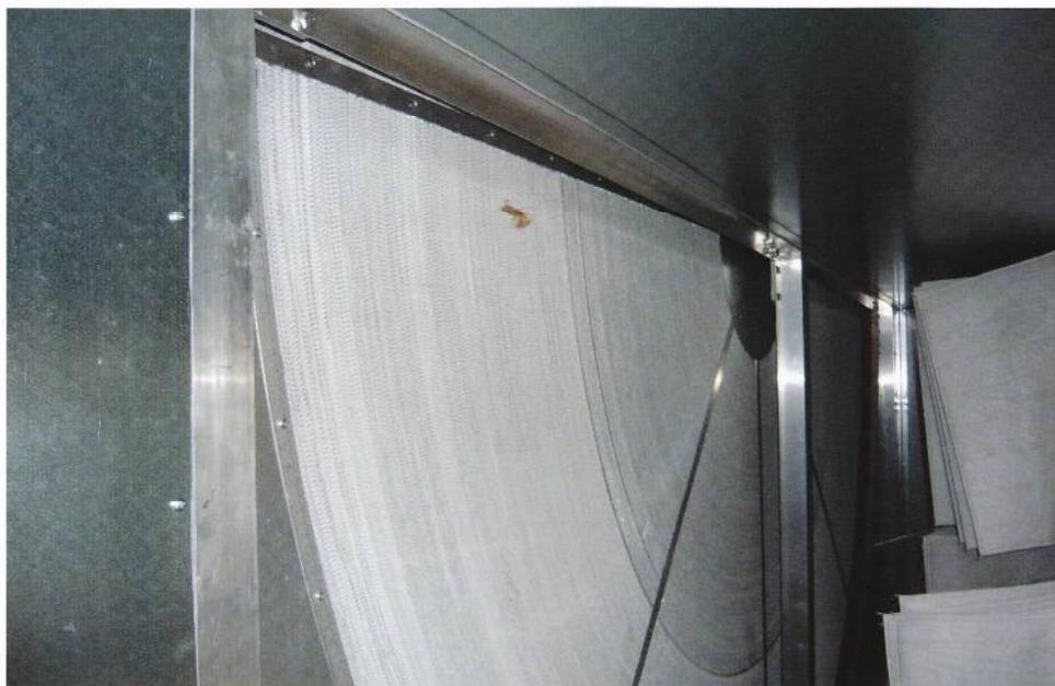
*Große Lüftungsanlage auf dem Dach zur Versorgung des Auditoriums. Detail: Rotor mit einer speziellen Beschichtung für Feuchteübertragung.*
