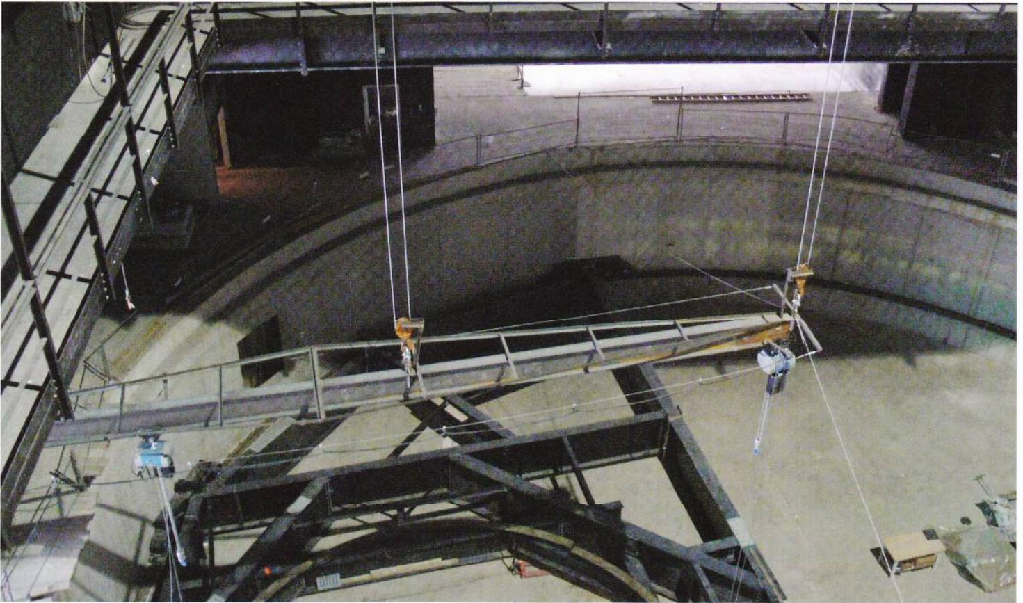
*Blick aus dem Bühnenturm auf das Untergeschoss, in dem mit Hilfskränen an der Transportdrehseibe gearbeitet wird. Seitlich und hinten die Gänge des Bühnenturms, das Licht kommt von der Hinterbühne.*
