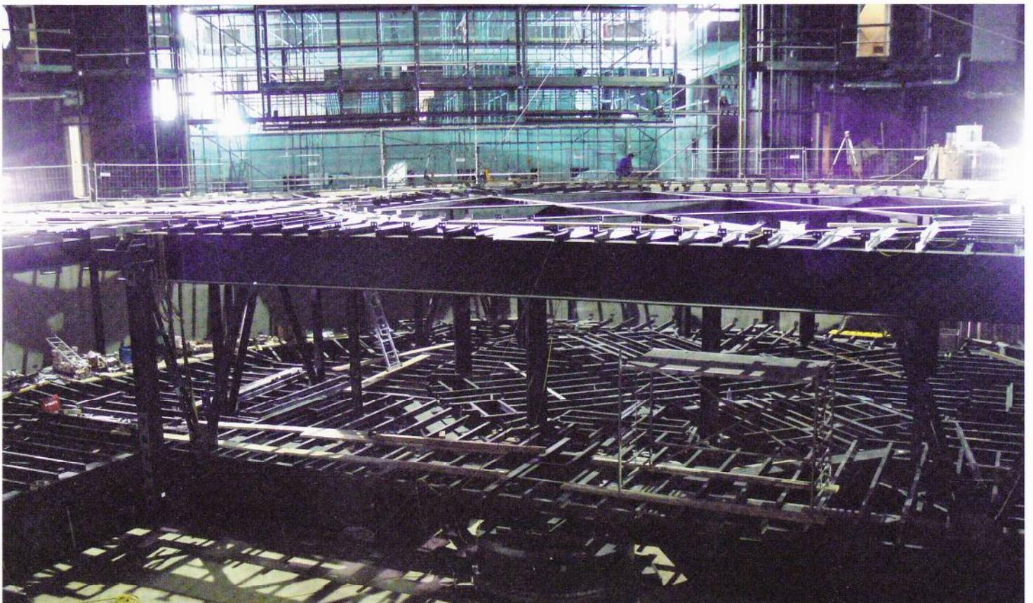
*Unteres und oberes Tragwerk der Transportdrehbühne mit der Spieldrehbühne. Vorne ist der Freiraum für 3 Hubpodien, unten gleich dahinter das Zentrallager. Im Hintergrund die Bühnenöffnung mit dem eingerüsteten Auditorium.*
