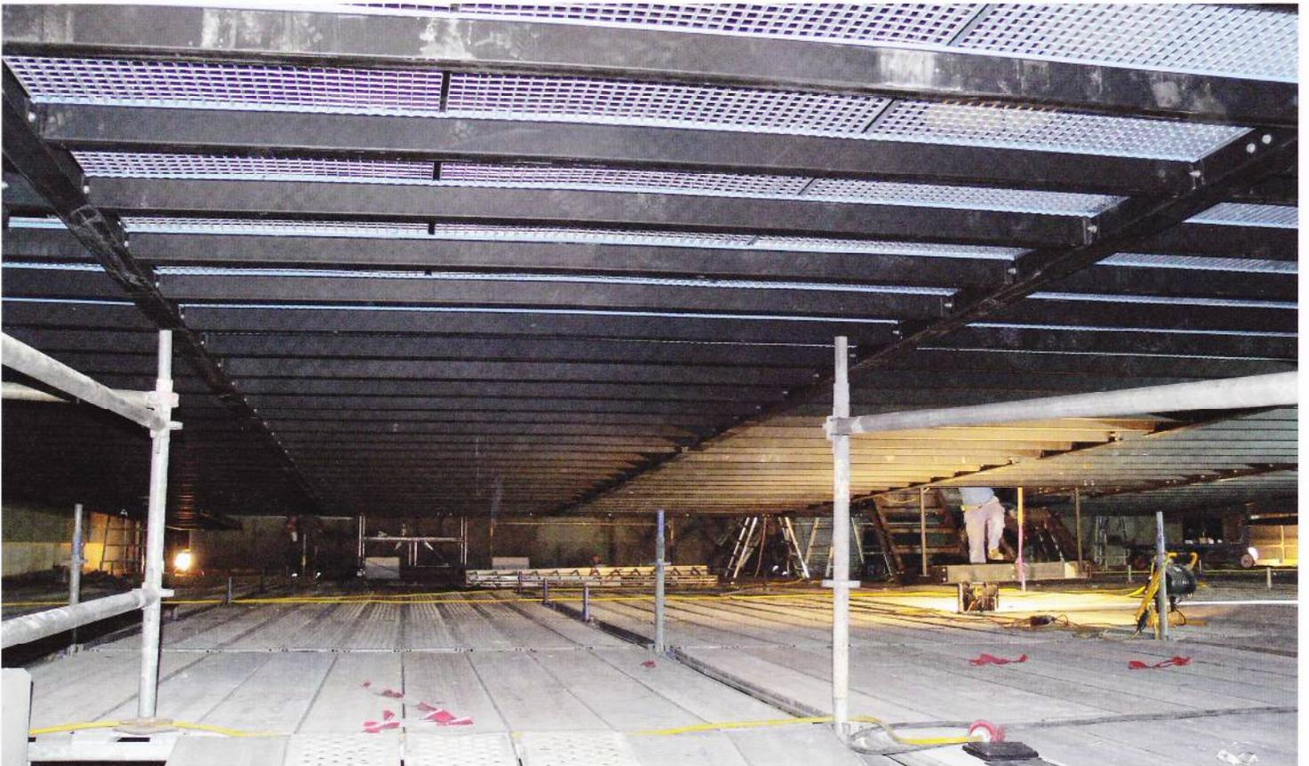
*Unter dem Dach des Auditoriums. Die untere Ebene ist eine vorläufige, auf dem Gerüst liegende Arbeitsbühne. Darüber, von unten zu sehen, ist die bleibende Wartungsbühne für den Theaterbetrieb, die an den Dachträgern hängt.*
