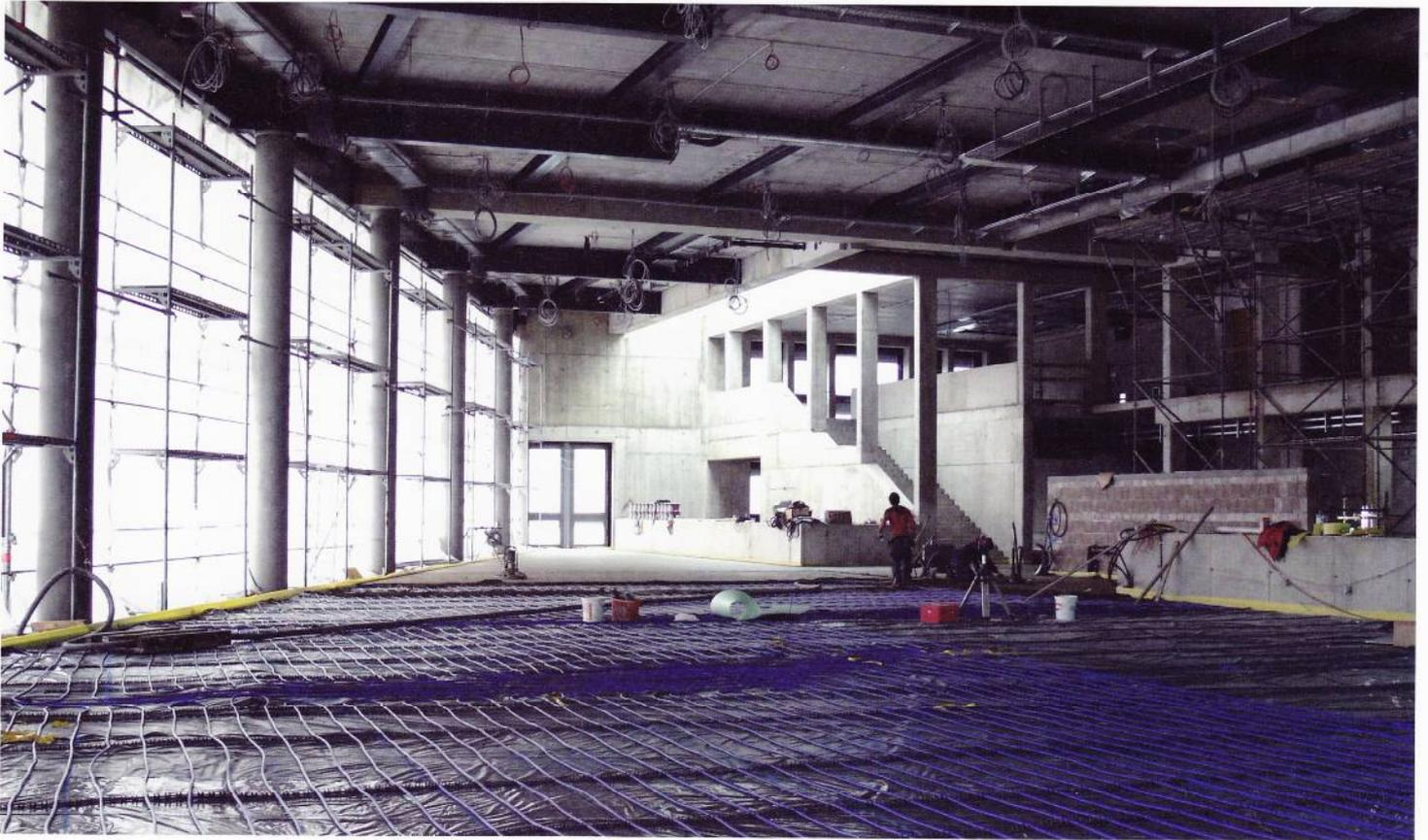
*Hauptfoyer. Verlegt wird derzeit die Fußbodenheizung.*
