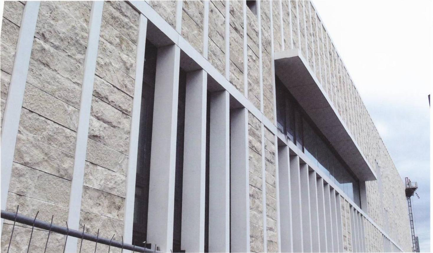
*Die Fassade aus weißen Stahlbetonfertigteilen mit Querschnitt 25/50 und der Ausfächung aus Naturstein (gespaltener Travertin aus den Brüchen in Tivoli - siehe auch Seite 2) ist an der Südwestseite weitgehend fertig.*
