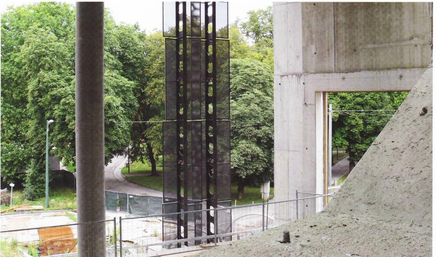
*Im Hauptfoyer sind bereits die ersten Tragelemente für die Glasfront der Westfassade montiert. Gut zu sehen die Flügel der herausgeklappten Beschattungseinrichtungen. Dahinter die Bäume des Volksgartens.*
