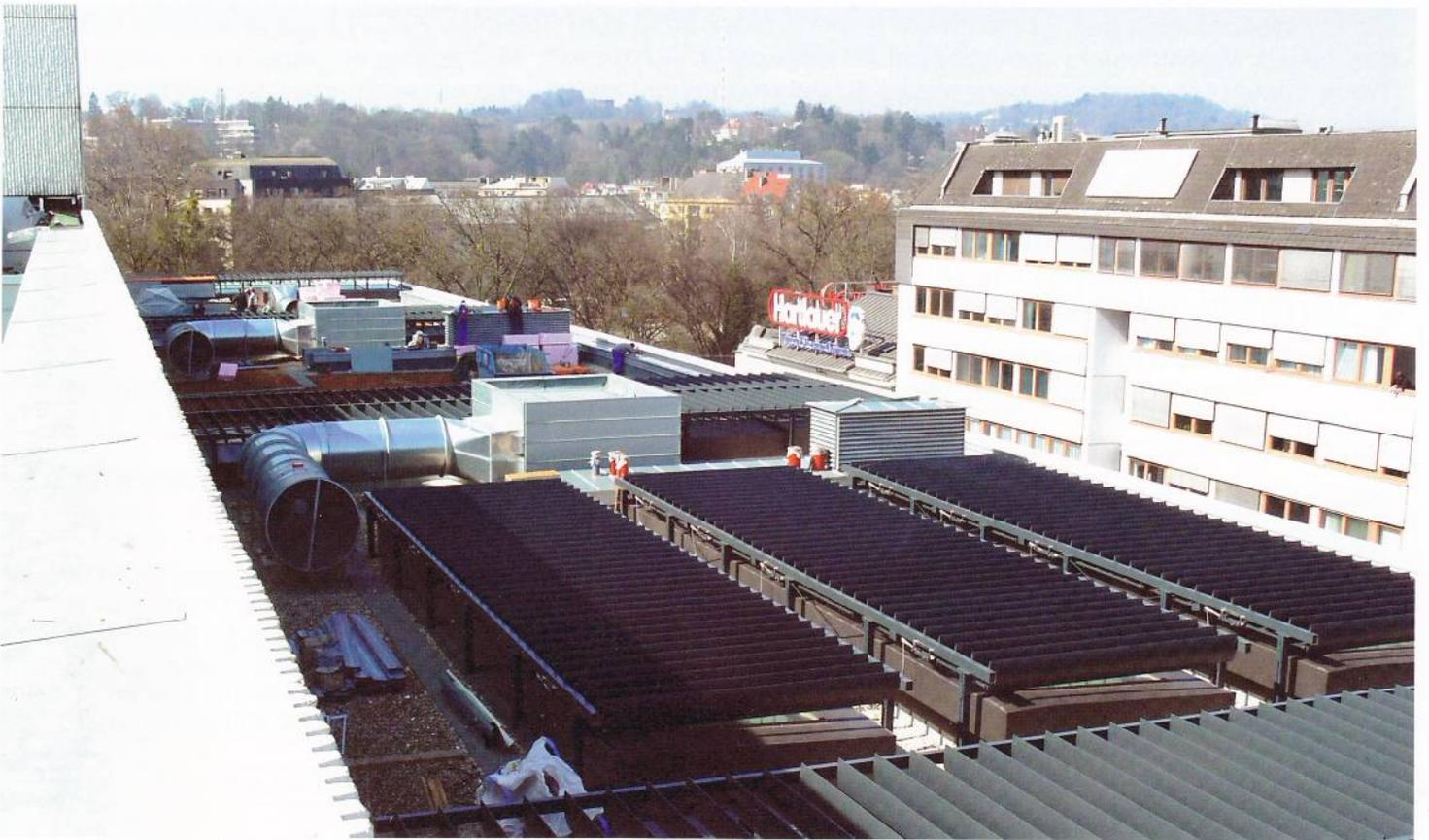
*Blick vom Dach des Atriumgebäudes hinunter auf das Dach des Künstlertraktes. In Bildmitte die 3 Dachflächenfenster des Ballettprobenraumes mit Sonnenschutzlamellen, dahinter Lüftungsanlagen.*
