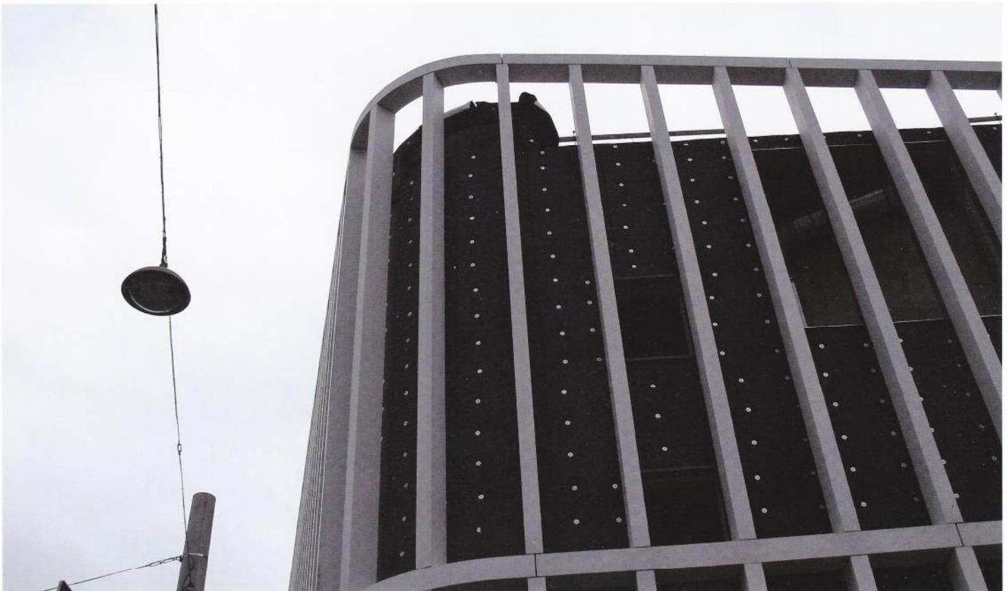
*An der Ecke Blumauerstraße/Südtirolerstraße warten die Stahlbetonfertigteile noch auf die Steinausfächung. Die schwarze Fläche zeigt die Dichtungsbahnen über der darunter liegenden Wärmedämmung.*
