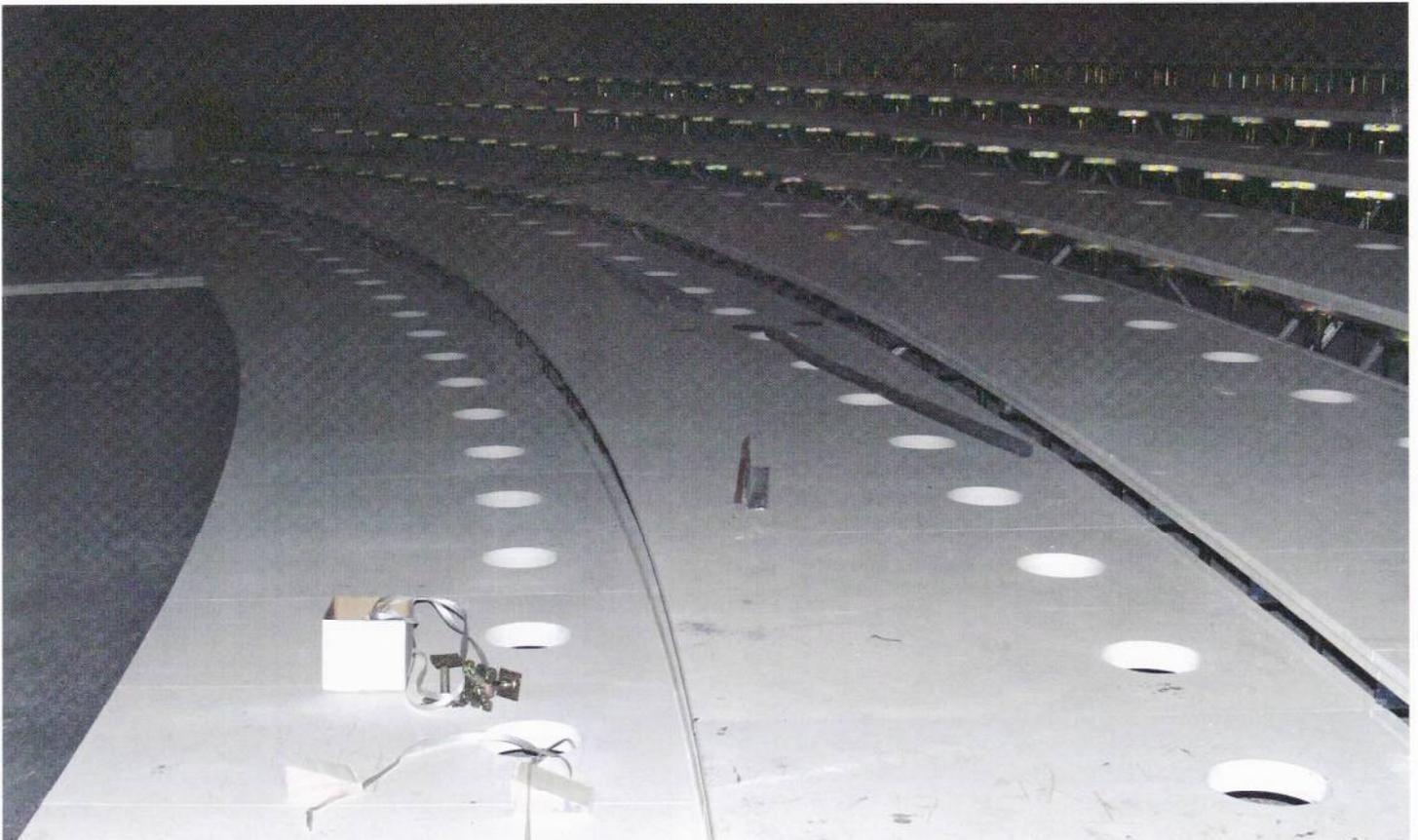
*Stufenkonstruktion im Parkett aus Kalziumsulfatplatten. Die runden Öffnungen dienen für die Zuleitung der Lüftung in die Lüftungsfüße der Bestuhlung.*
