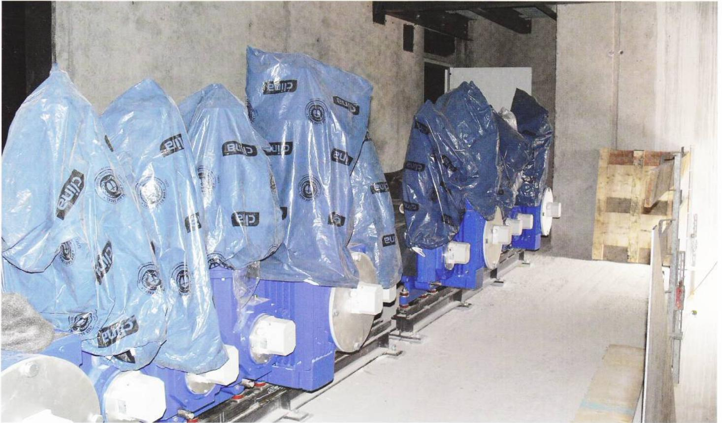
*Die Antriebsmotoren der Prospektzüge sind ein Stockwerk tiefer bereits in Stellung. Aus Schallschutzgründen liegen diese seitlich außerhalb des eigentlichen Bühnenturms.*
