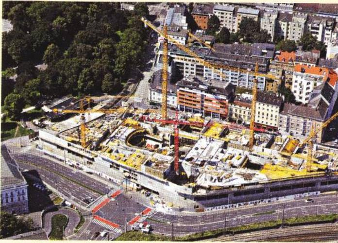
**Der Bau strebt mit beachtlicher Geschwindigkeit nach oben: Der Zuschauerraum links im Bild ist schon weit gediehen, in Bildmitte ist schon das Bühnenportal zu erkennen und dahinter die kreisförmige Öffnung für die Transportdrehbühne**
