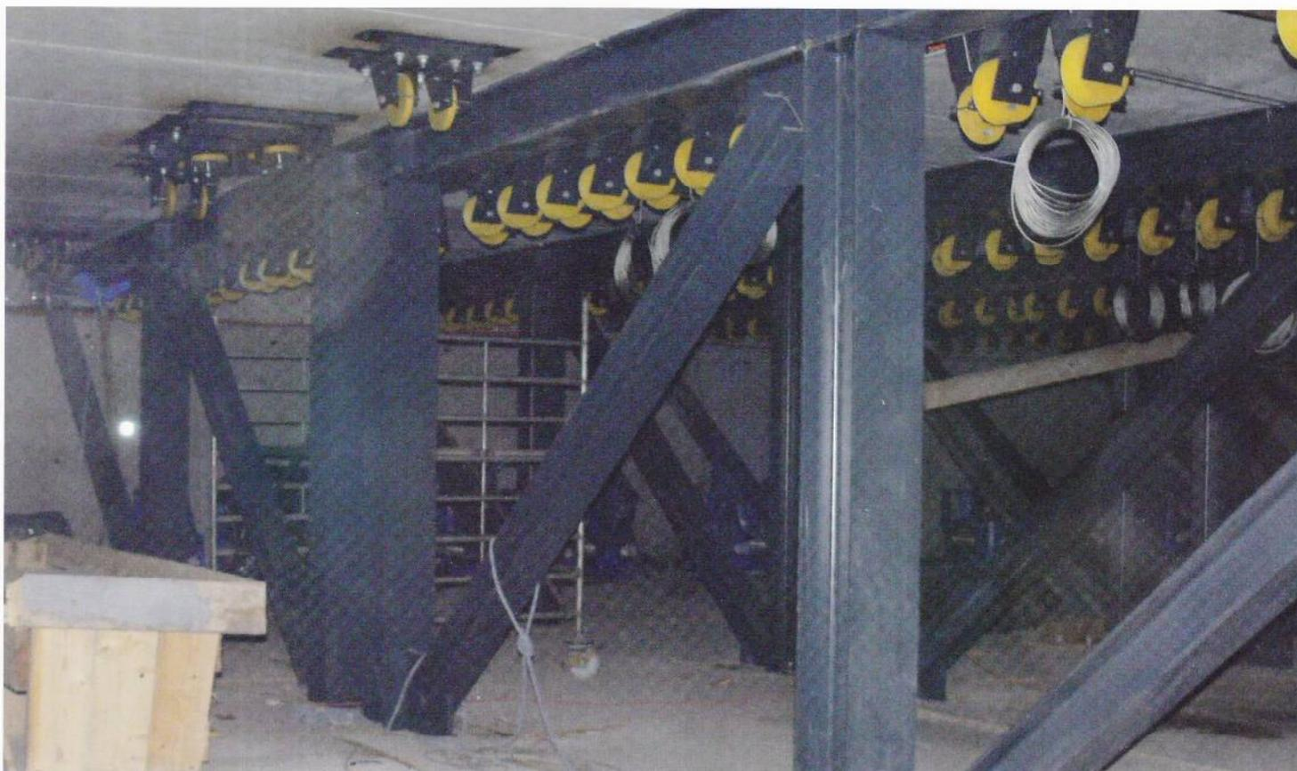
*Die Dachkonstruktion des Bühnenturms und die Umlenkrollen für die Prospektzüge. Beim Anblick der dünnen Stahlseile kann man an die dicken Hanftaue denken, die früher im Alten Haus verwendet wurden.*
